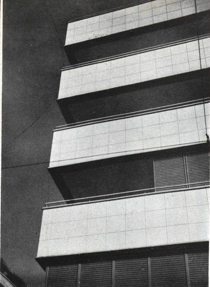
*Persianas de hormigón premoldeado, colocadas en un edificio de oficinas en Milán. Son de lamas accionables, y cada elemento se desplaza lateralmente, con lo que se consiguen unas máximas posibilidades de utilización.*
